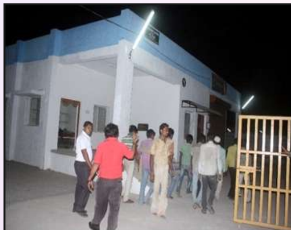
कलाली एरिया, वडोदरा में 2 नाइट शेल्टर का निर्माण
